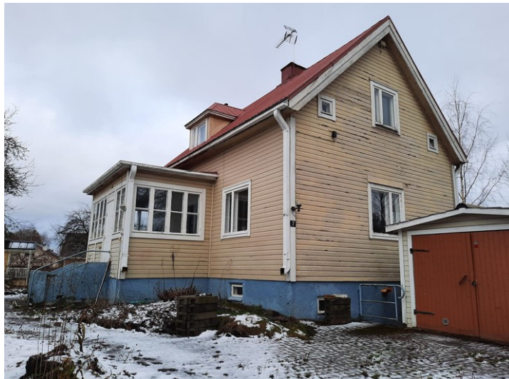
Kuva 1. Näkymä tontille. Kuvassa näkyvät rakennukset ovat saaneet purkuluvan. © Tampereen kaupunki 2021
